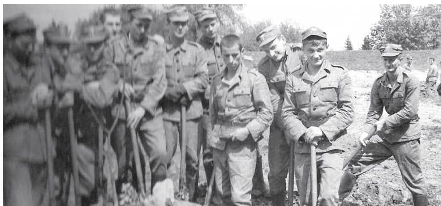
Szer. Jerzy Mroczyński z kolegami na budowie strzelnicy
